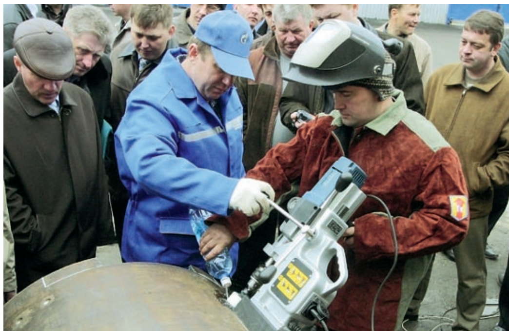
Установка на трубу оборудования безогневой вырезки технологических отверстий
